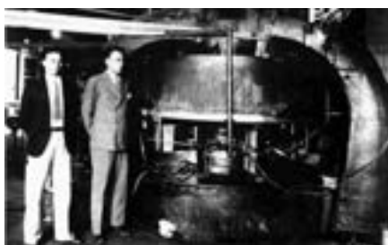
Американският физик Ернест Лорънс и изобретеният от него първи циклотрон през 1931 г.
