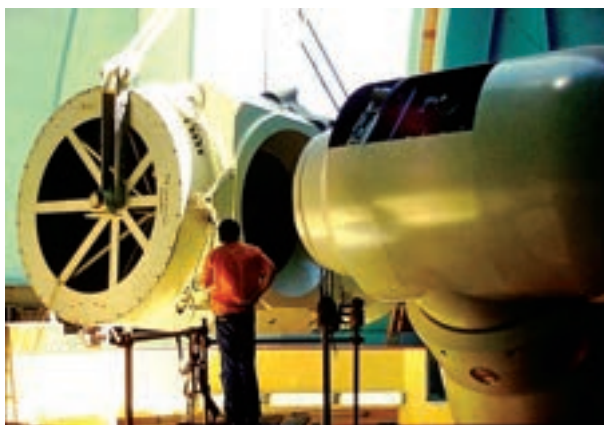
Монтаж на тубуса (инж. П. Христов)
