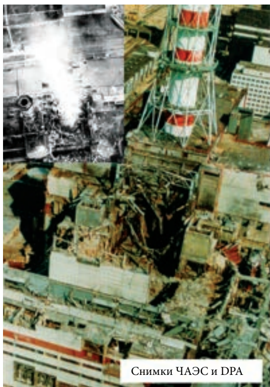
Две въздушни снимки на разрушения четвърти блок на Чернобилската АЕЦ. Черно-бялата е направена дни след аварията и показва горящия реактор. Цветната снимка е направена по-късно след пълното потушаването на пожара
