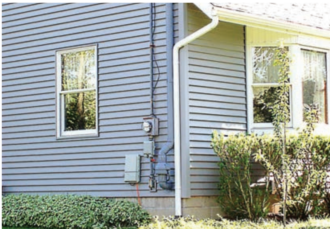
Система от тръби в основите, свързани с вентилатор, изхвърля придошлия от почвата въздух директно в атмосферата
